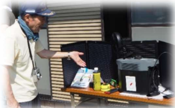
藤川区自主防災組織 ポータブル電源 (防災訓練にて)
